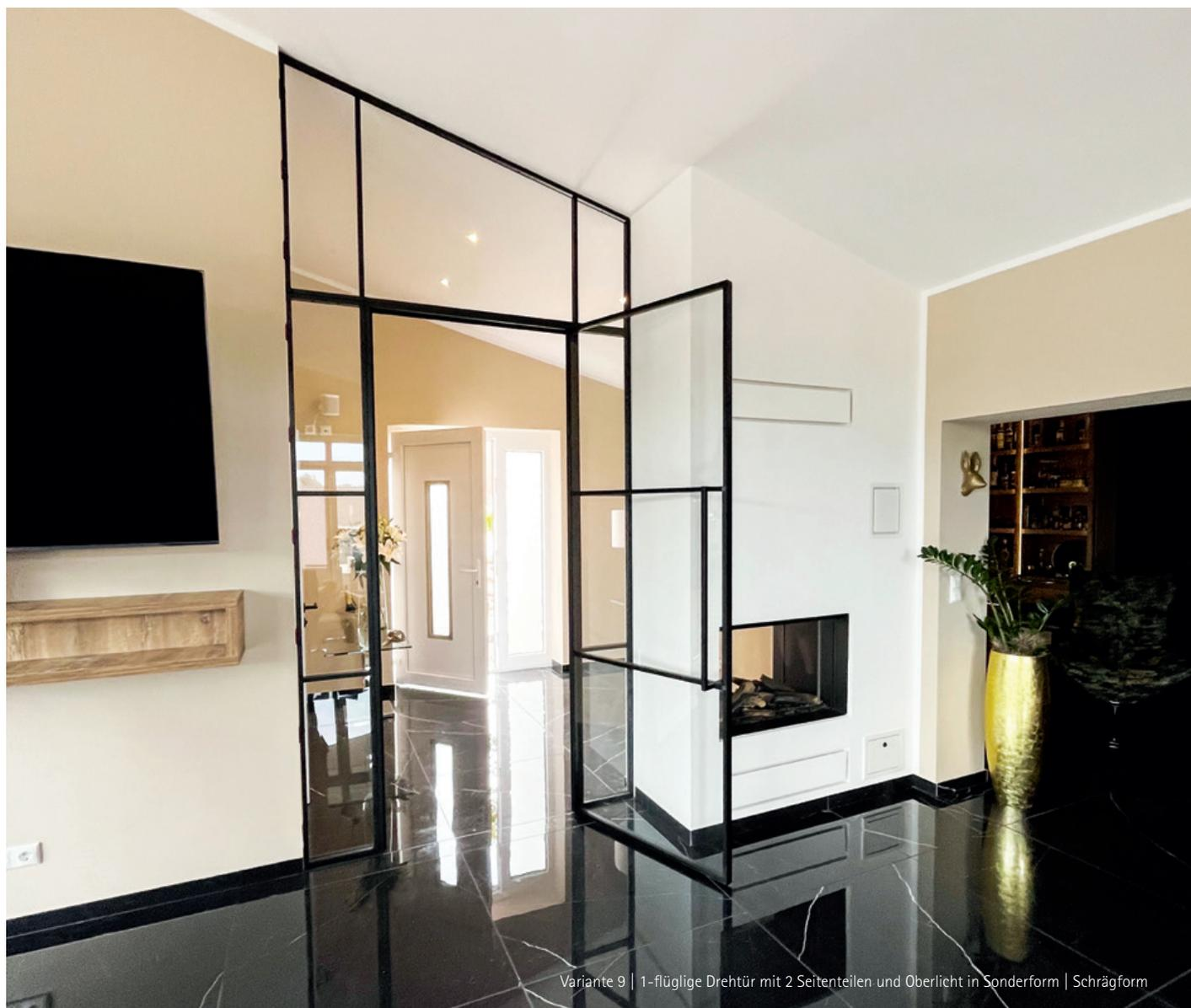
Variante 9 | 1-flügelige Drehtür mit 2 Seitenteilen und Oberlicht in Sonderform | Schrägform
